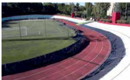
▲ Vista del velódromo que se está renovando..
