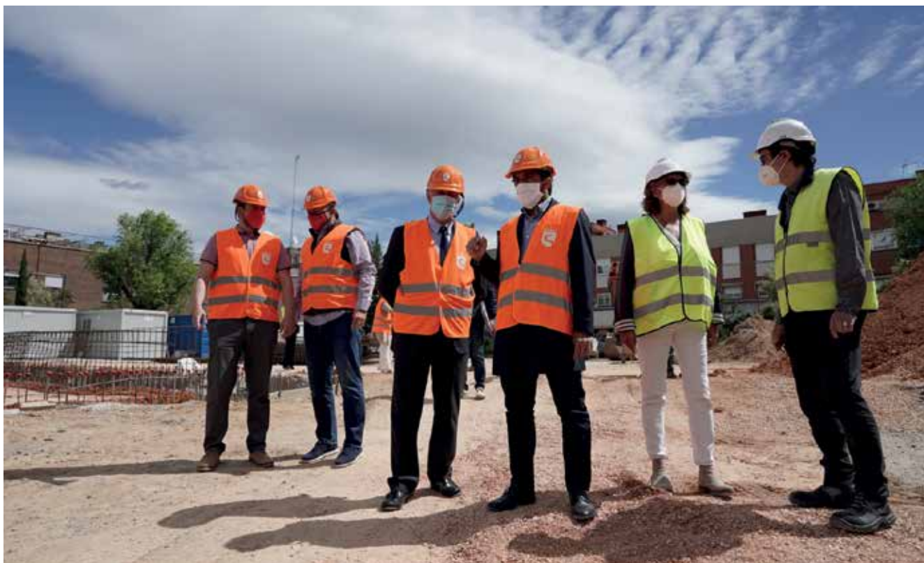
▲ El alcalde y vicecalde, con los técnicos municipales, en la zona donde se están acometiendo las obras.
