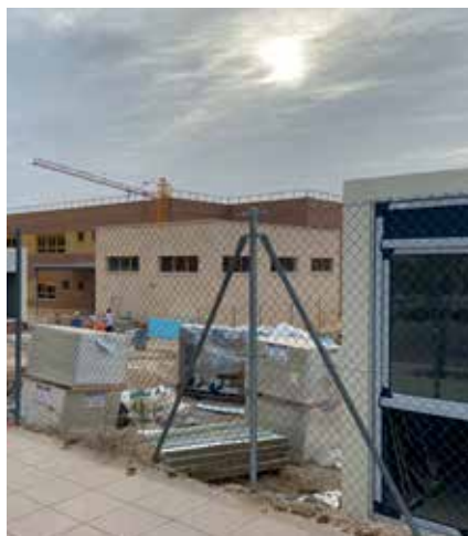
▲ Obras en el CEIP Tempranales.
